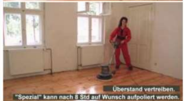
oder mit Poliermaschine (grünes Pad) einarbeiten
